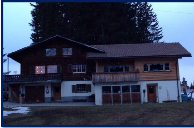
Wohnhaus Geissgrind Hanspeter und Agnes
